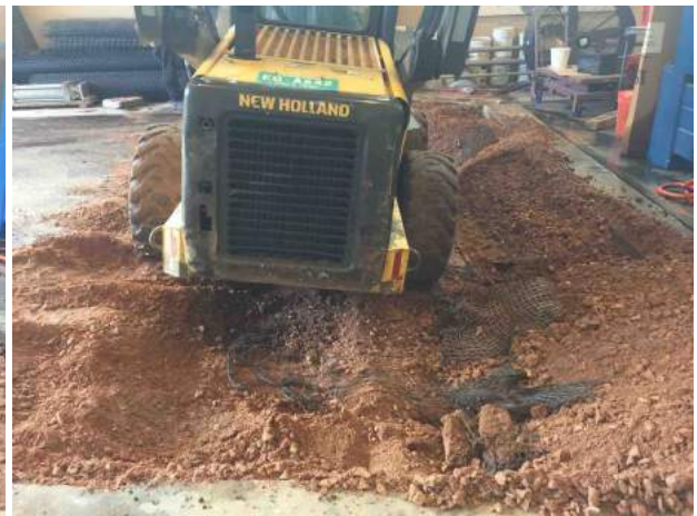
(d) Removing Aggregate Base Layer
