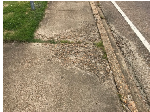
SPALLING
