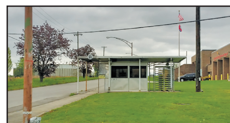
Guard Portal at K-25 (ETTP)
