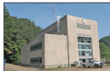
Ocoee No. 3 Dam.
