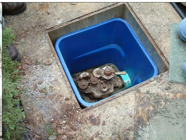
Saampii hin qabamne meeshaa pilaastikii fayyadamuun akka duubatti guutuun mataa paampii irratti akka hin nam'ine godha. Kun ulaagaalee dhaabbii amma jiran hin guutu.
