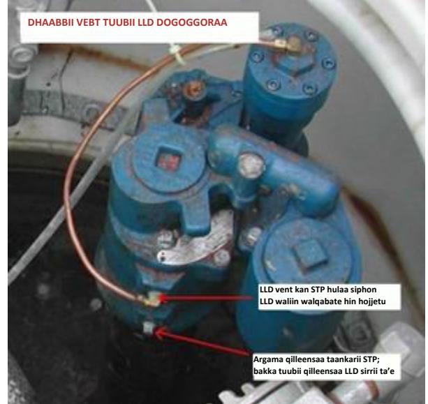
Dhaabbii tuubii qilleensaa MLLD sirrii hin taane (buufata saayifoonii gubbaa); MLLD hin hojjetu.
