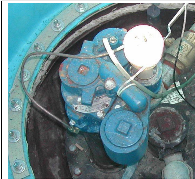
FE Petro 潜没泵（储油罐底部口）上的机械式管道检漏仪（MLLD）通风管安装正确。
