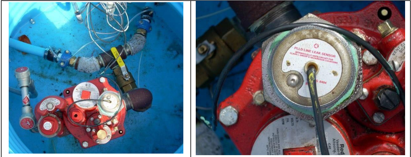
Veeder Root 加压管道检漏仪 (PLLD)
