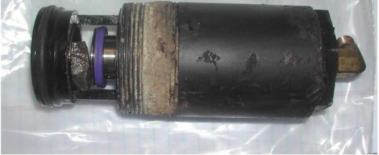
插入岩石以禁用管道检漏仪
