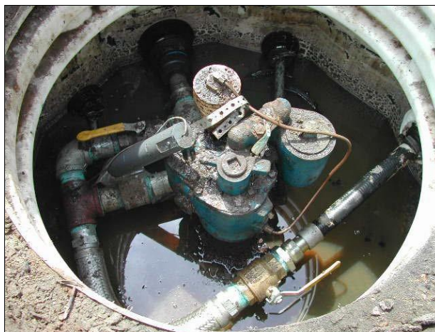
集液槽和传感器中的水和产品已从该位置清除，无法正确检测集液槽中的液体
