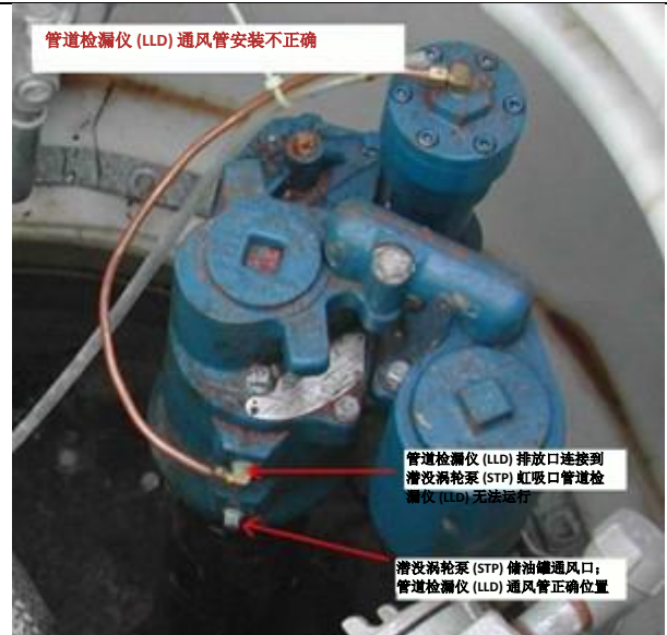
机械式管道检漏仪（MLLD）通风管安装不正确（上虹吸口）；机械式管道检漏仪（MLLD）无法运行。
