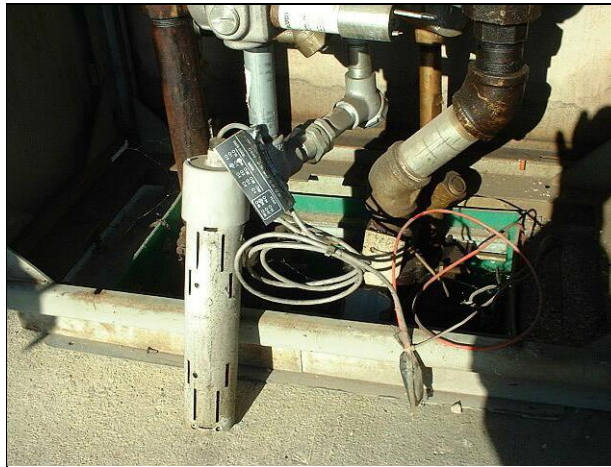
带传感器的浅型加油机下密封集液槽
