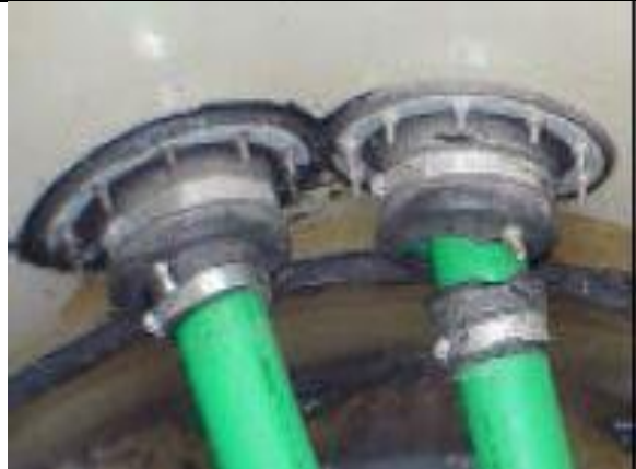
2. 连接到渗透管件的 Environ Geo-Flex 测试套；右侧测试套
