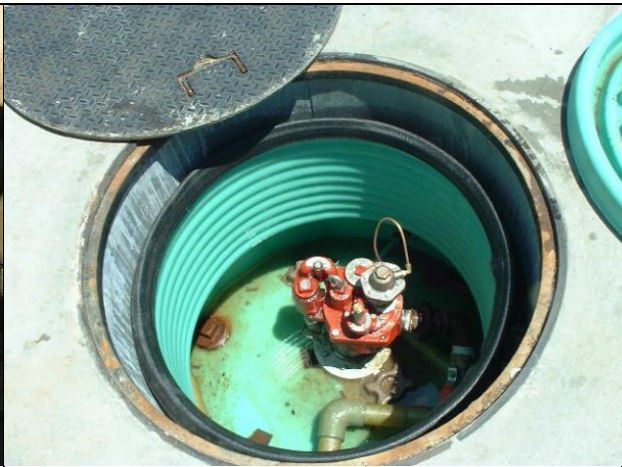
典型潜没涡轮泵 (STP) 集液槽的集液槽盖和罩
