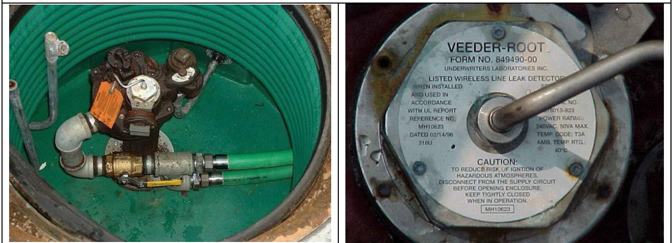
Veeder Root 无线加压管道检漏仪 (WPLLD)
