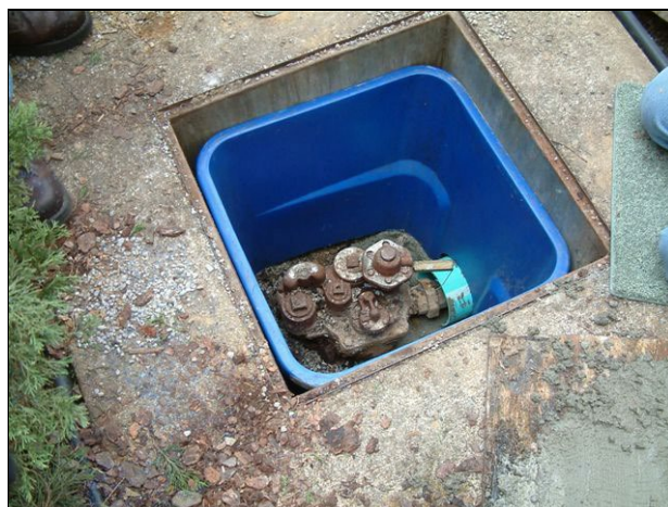
حموزی کونترۆل نهکراو به بهکار هینانی کۆنتهنهیریکی پلاستیکی بۆ پاراستنی پرکردنمه بگهریتمه سمری پهپهکه نهمه بهگۆیرهی ستاندره مکانی نیستای دامزراندن نابینت.
