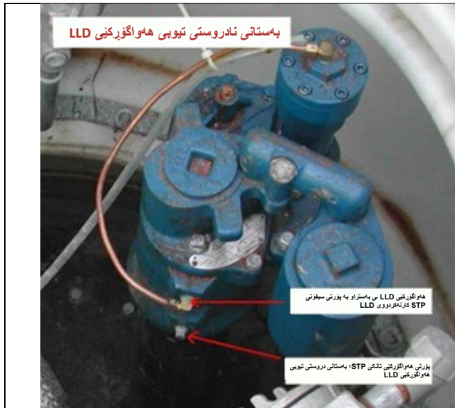
بەستانی نادروستی تیوبی ھەواگۆرکینی LLD ھەواگۆرکینی LLD ی بۆ پۆرتی سیفۆنی پۆرتی ھەواگۆرکینی تانکی STP، بەستانی نادروستی تیوبی ھەواگۆرکینی LLD
