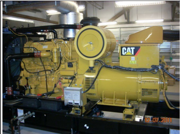
سېستەمەكانى UST مۆلىدە بارى لەناكاو كەوا بە ماددە رېكخەر سووتەمەنپان پېدەدرېت وەك دېزىل ئەمە لە لايمەن فەرمەنگە رېك دەخرېن.
