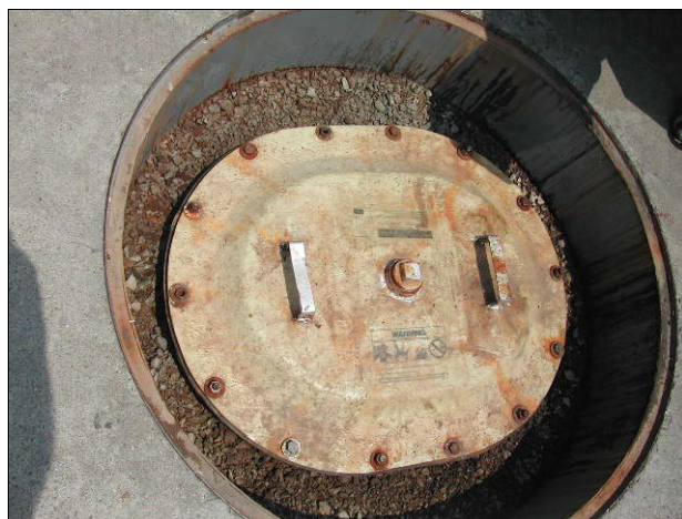
حموزی شیوه-هیلکیمی سمر تانکی پلاستیکی به هیزکراوی فایبرگلاس (FRP)
