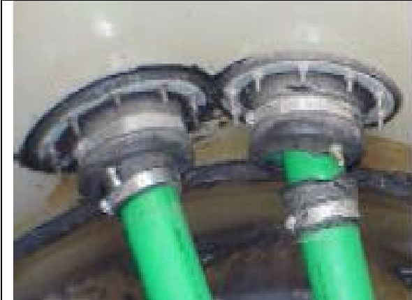
2. بووتی تاقیکردنموی Environ Geo-Flex سی بهستراو به کهرستهی چونه ناومه؛ بووتی تاقیکردنموی له لای راسته
