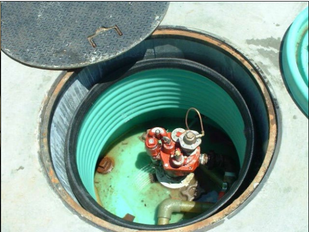
선프 뚜껑 및 덮개를 보이는 일반적인 STP 선프
