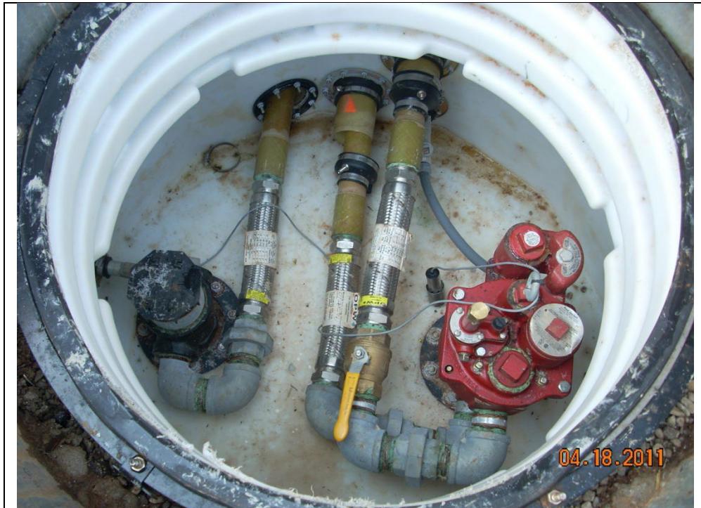
가압 비상 발전기 시스템에는 틈새 센서가 설치되어 있습니다.
