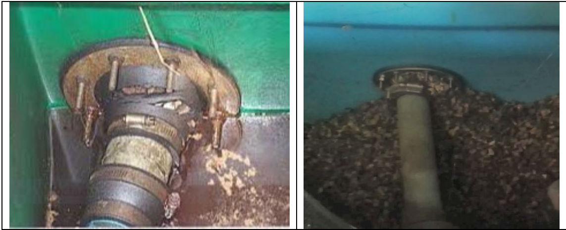
위의 사진은 자갈이 선프에 다시 채워질 수 있도록 손상된 관통 연결구를 보여줍니다. 선프는 더 이상 수밀 상태가 아닙니다.
