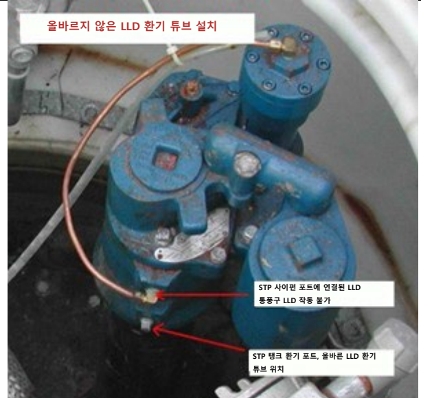
올바르지 않은 MLLD 환기 튜브 설치(사이펀 포트 상단), MLLD 작동 불가.
