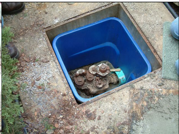
뒤채움이 펌프 헤드에 매몰되지 않도록 하기 위해 플라스틱 용기를 사용하는 격납되지 않은 선프. 이것은 현재의 설치 기준을 만족하지 않을 수 있습니다.
