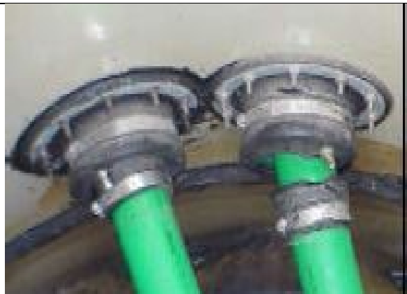
2. 관통 연결구에 부착된 Environ Geo-Flex 테스트 부트, 오른쪽 테스트 부트
